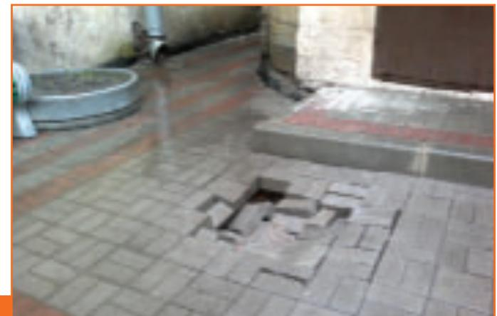
Разрушение мощения из-за неправильно организованного водоотвода
