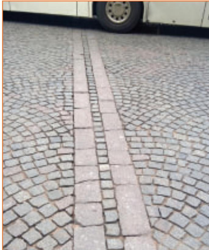
Разрушение плит мощения в зоне проезжей части
