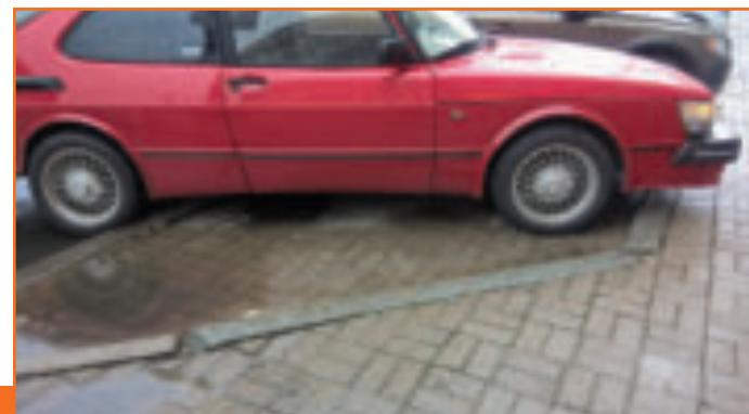
**Деформация дорожного покрытия из бетонных камней на автомобильной парковке**
