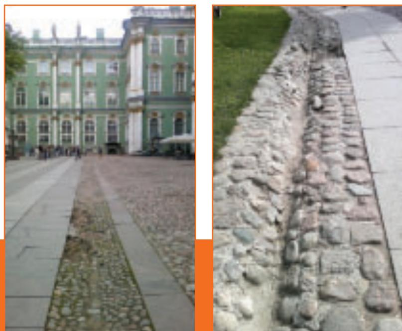
Разрушение водосборного канала (лотка) и прилегающего покрытия
