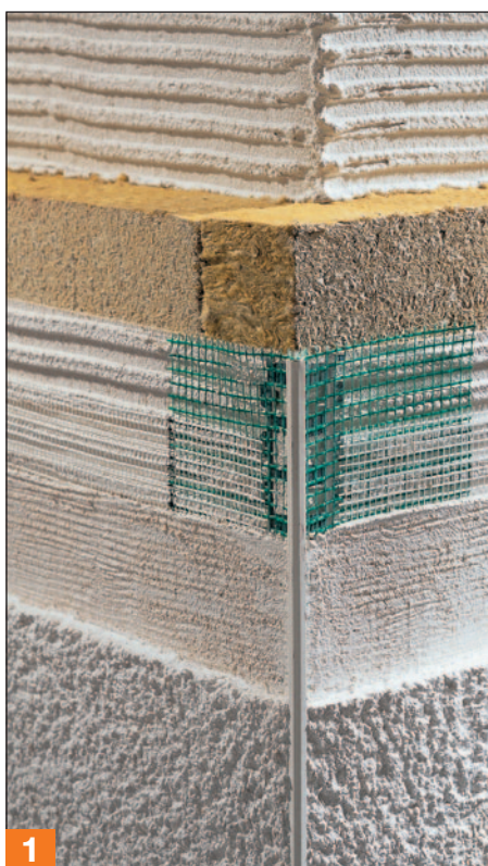
1. Заделка кромок
