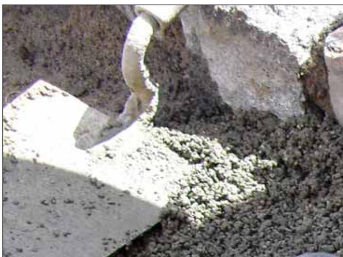
Укладка булыжника на раствор TDM
