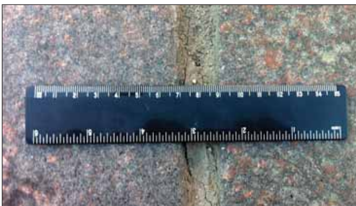
Рис. 7. Мощение прямолинейными рядами из гранитной шашки. Швы 15- 25 мм.
