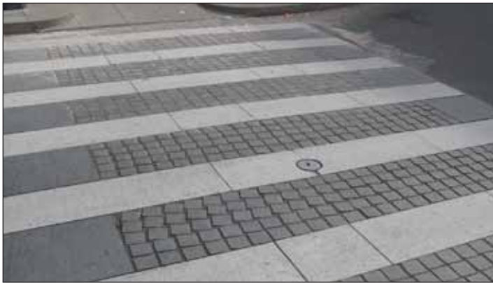
Рис. 6. Разрушение мощения наземного пешеходного перехода на участке автомобильной дороги
