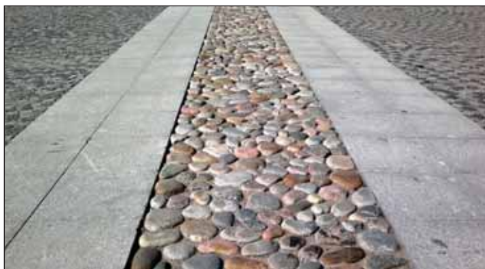
Рис. 19. Фрагмент участка дорожного покрытия на территории Петропавловской крепости
