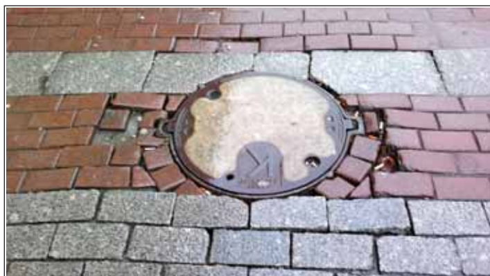
Рис.11. При мощении не соблюдаются правила выполнения примыканий
