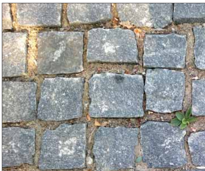
Рис.10. Неудовлетворительное мощение из гранитной шашки и булыжного камня из-за отсутствия сортировки камней
