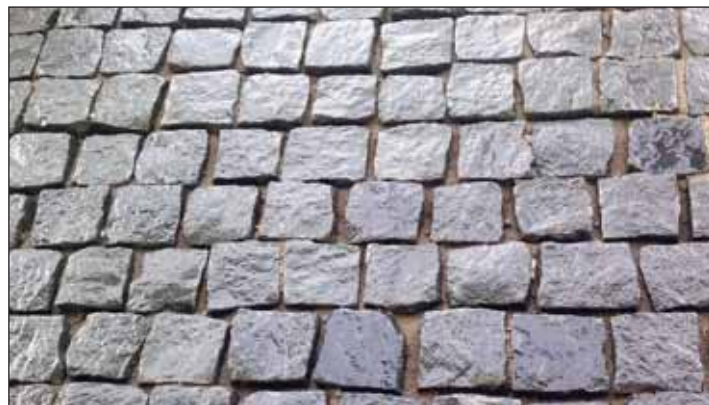
Расшивка швов на глубину не менее 30 мм
