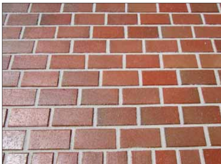
Рис. 33. Дорожная одежда с покрытием из клинкерного кирпича с использованием растворов на основе вяжущих:
