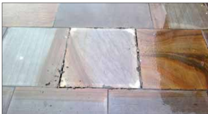
Рис. 9. Крупные плиты не устойчивы в покрытии
