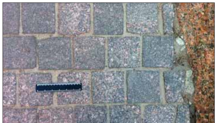
Рис. 7. Мощение прямолинейными рядами из гранитной шашки. Швы 15- 25 мм.
