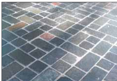
Рис. 14. а. Заполнение швов в дорожном покрытии из брусчатки контрастным раствором
