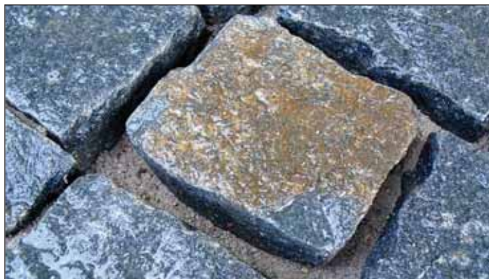
Расшивка швов на глубину не менее 30 мм
