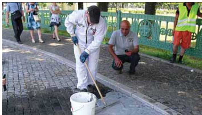
Распределение по поверхности дорожного покрытия раствора с тщательным заполнением швов
