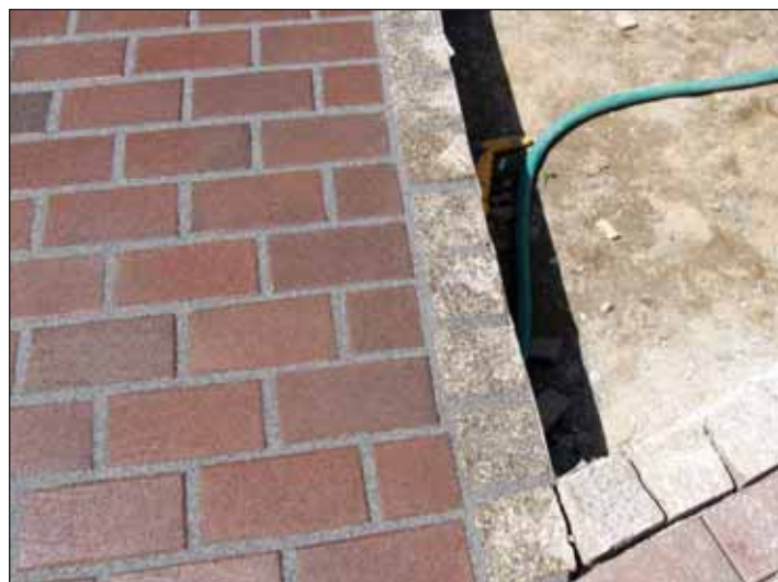
Рис. 34 . Заполнение швов в мощении из клинкера раствором
