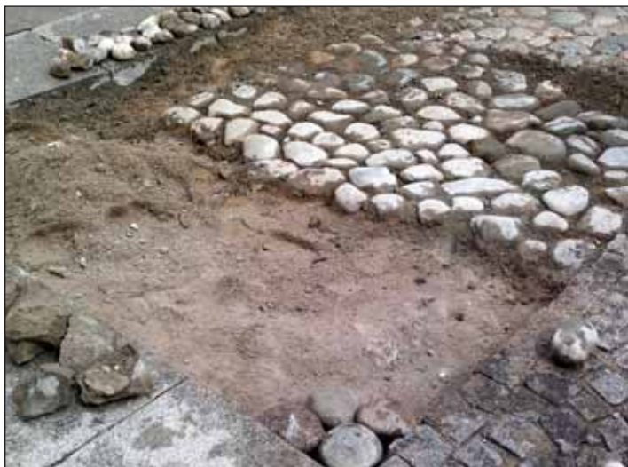
Захватка 1. Вскрытие булыжного мощения
