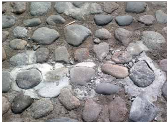
Рис. 22. Закрепление булыжных камней с помощью цемента-песчаного раствора не является эффективным
