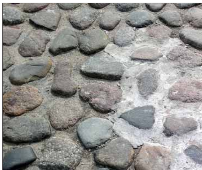
Рис.10. Неудовлетворительное мощение из гранитной шашки и булыжного камня из-за отсутствия сортировки камней
