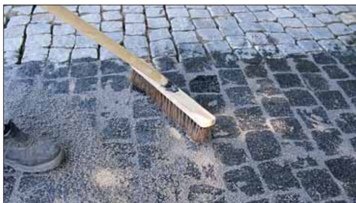
Подметание поверхности мощения щеткой
