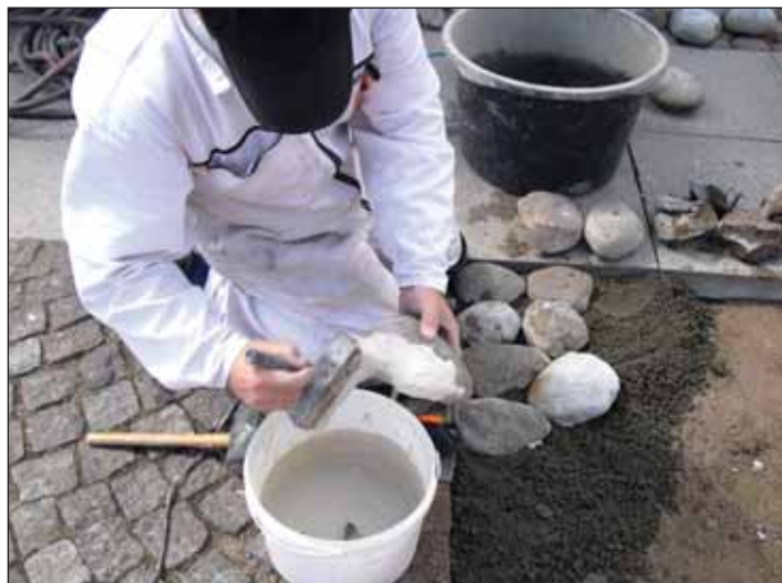
Обработка основания булыжника адгезионным раствором
