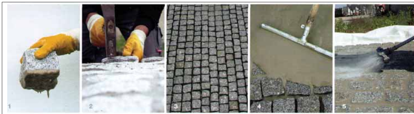
Рис. 18. Пример применения растворов на основе трассово-цементных вяжущих при мощении естественными каменными материалами
