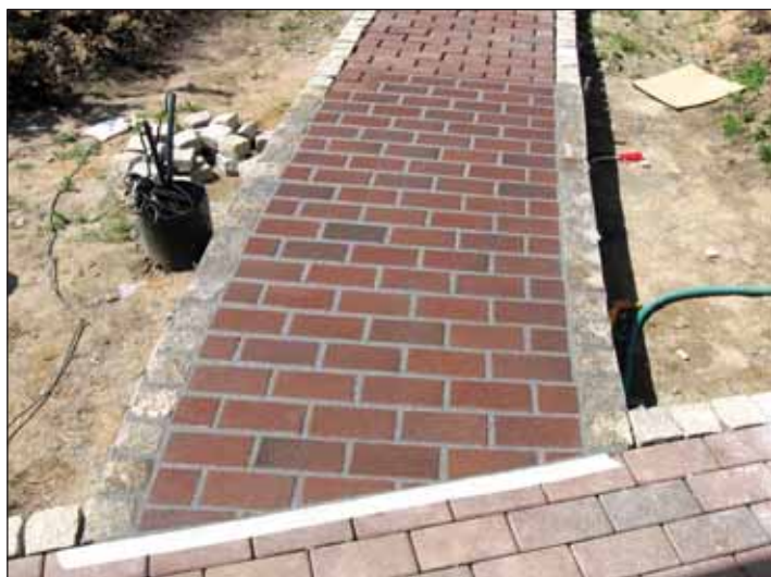
Рис. 34 . Заполнение швов в мощении из клинкера раствором
