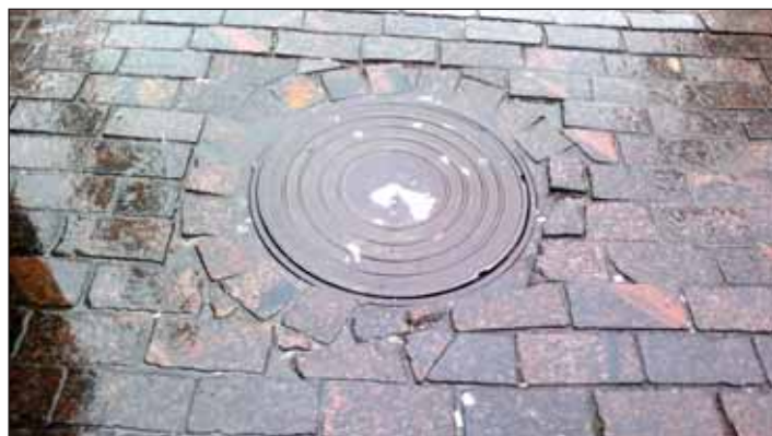
Рис.11. При мощении не соблюдаются правила выполнения примыканий
