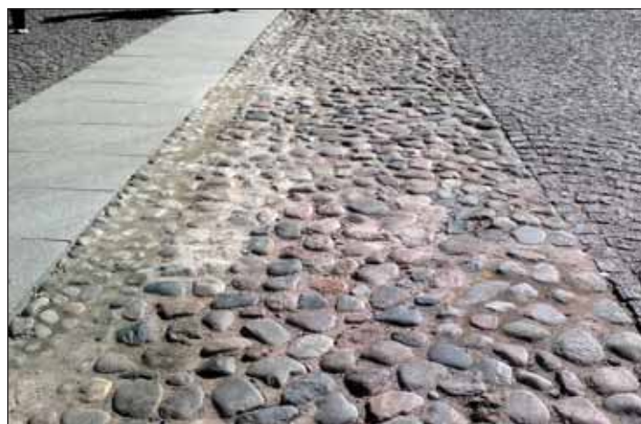
Рис. 23. Расположение и общий вид участка мощения для демонстрации растворов. На фото слева вдоль гранитных плит виден водосборный лоток
