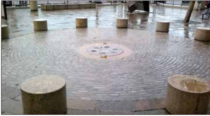
Рис. 4. Применение мощения при устройстве бесчашных фонтанов - швы в зоне риска
