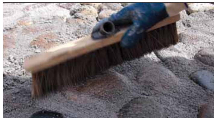
Удаление остатка раствора. Очистка булыжника
