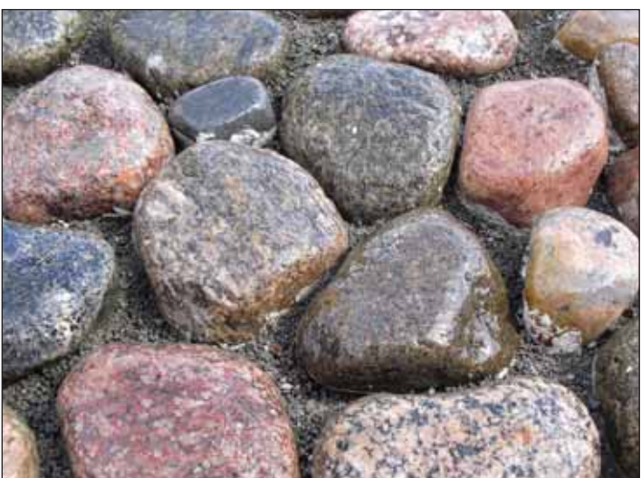
Булыжник после укладки на дренажный раствор
