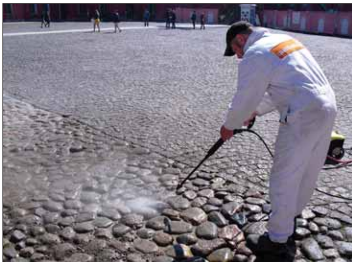
Расчистка швов факелом воды под высоким давлением
