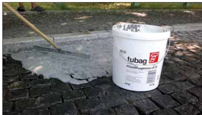
Распределение по поверхности дорожного покрытия раствора с тщательным заполнением швов
