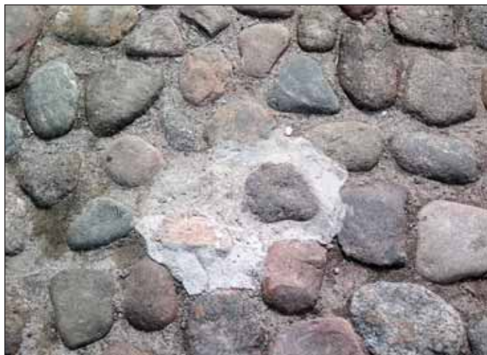
Рис. 22. Закрепление булыжных камней с помощью цемента-песчаного раствора не является эффективным
