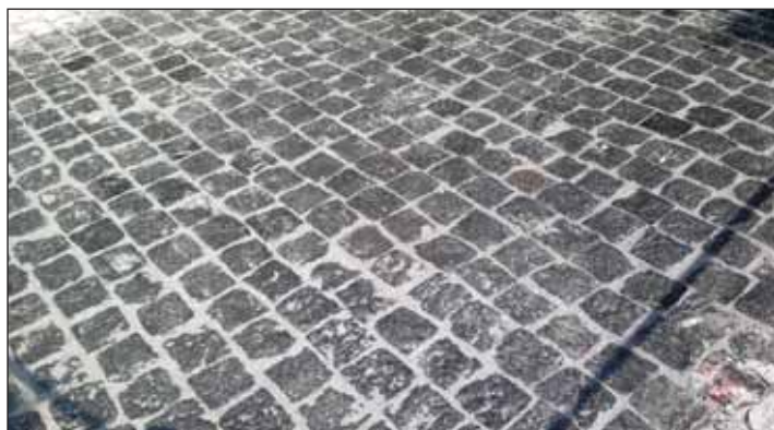
Участок покрытия с заполненными швами
