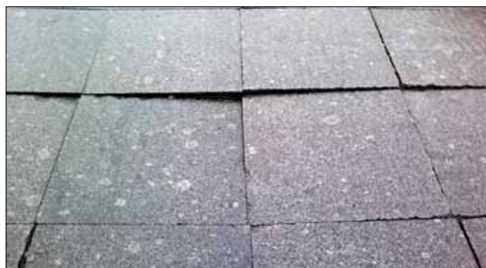
Рис. 9. Крупные плиты не устойчивы в покрытии
