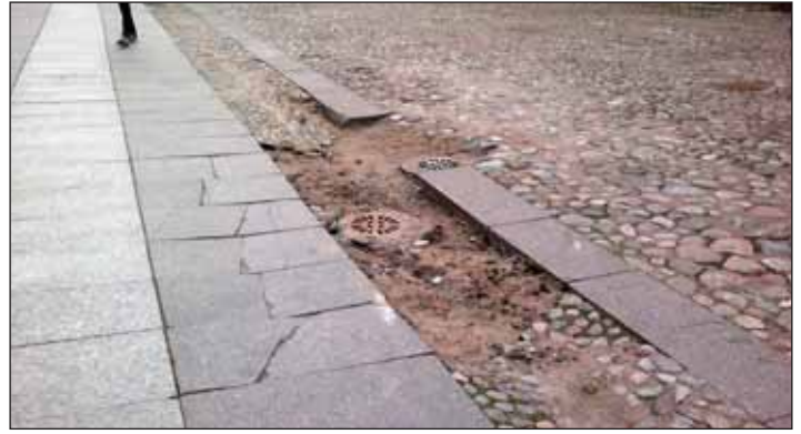
Рис. 5. Мощение, примыкающее к элементам водосборной системы (водосточные трубы, лотки и т. д.) легко размывается водой
